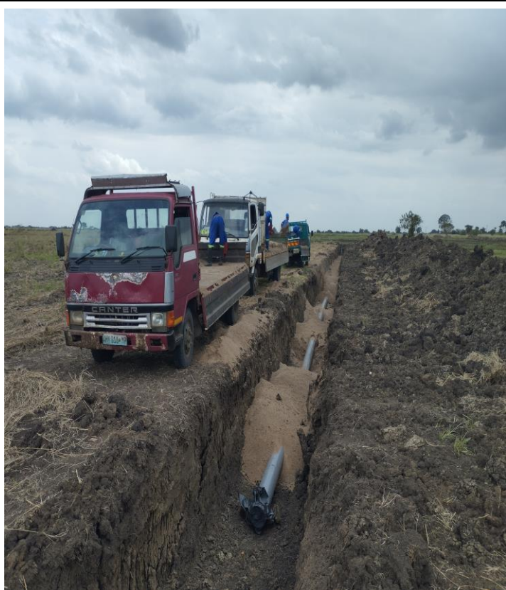
Foto 12: Colocacao da almofada para assentamento da Tubagem
