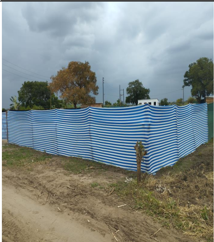
Foto 9: Foto 8: Vedacao do estaleiro de obra
