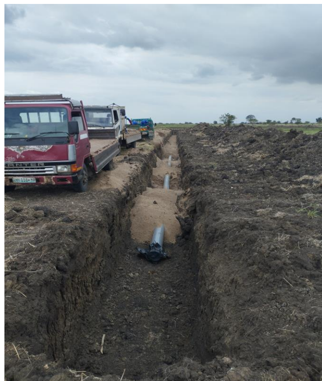
Foto 13: Colocacao da almofada para assentamento da Tubagem
