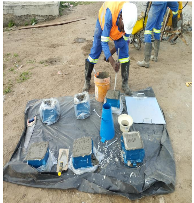
Foto 8: Extração de corpo de Prova para a testagem do betão
