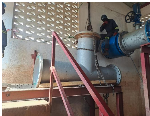
Remoção da tubagem na estação de bombagem para limpeza e a seguir possível reuso
