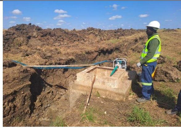
Drenagem da rede através da válvula de descarga
