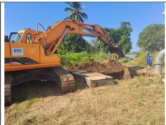
Escavação para o tubo Bypass
