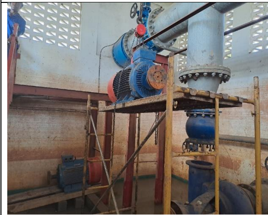
Remoção das Bombas
