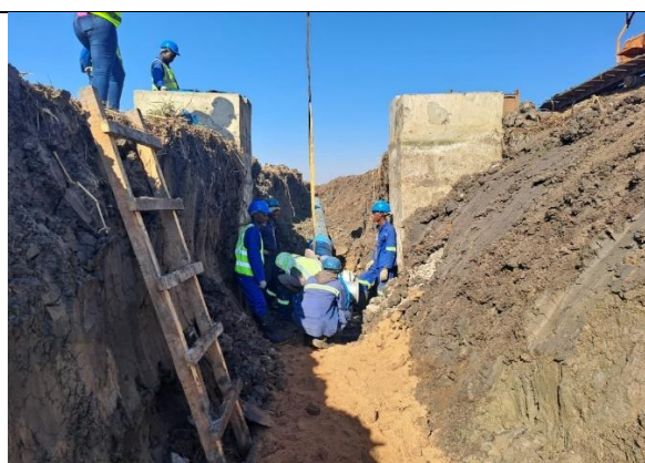
Instalação de nova tubagem e acessórios
