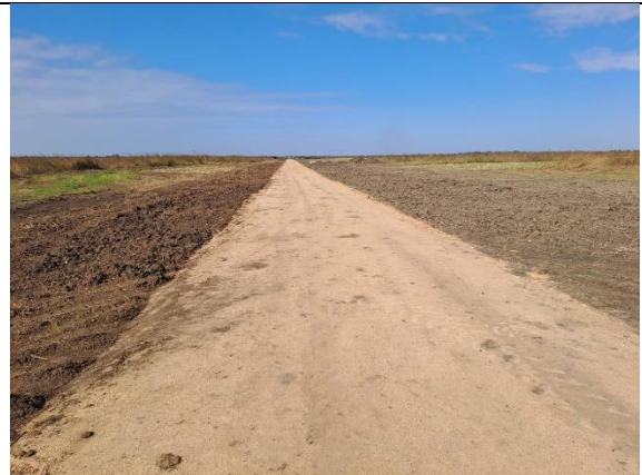
Regularização das Bermas das Estradas para abertura de Valetas de água
