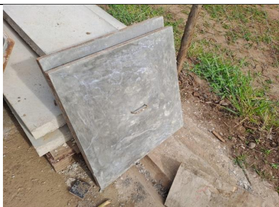
Fabrico de Tampas para reposição das destruídas pelas Cheias
