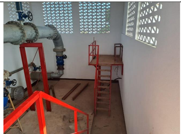
Tubagem na estação de bombagem Já conectadas aguardando apenas pelas Bombas
