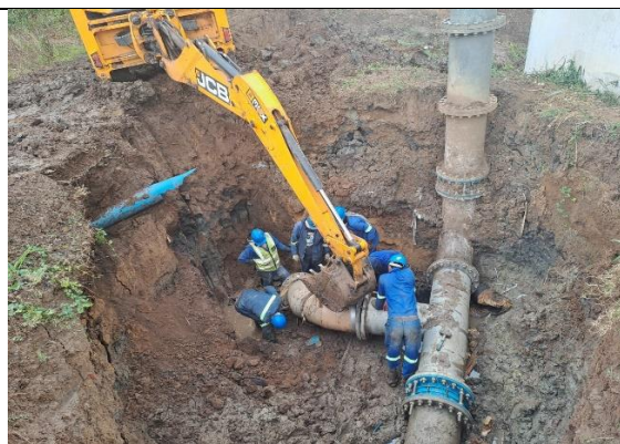
Montagem do Te o Curva no Bypass
