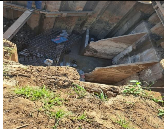
Preparação dos maciços das Bombas na captação
