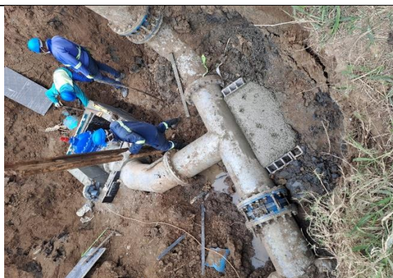
Construção da Caixa de Válvulas do Bypass
