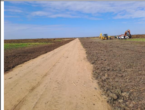
Regularização das Bermas das Estradas para abertura de Valetas de água
