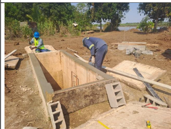
Retoques nas caixas de válvulas
