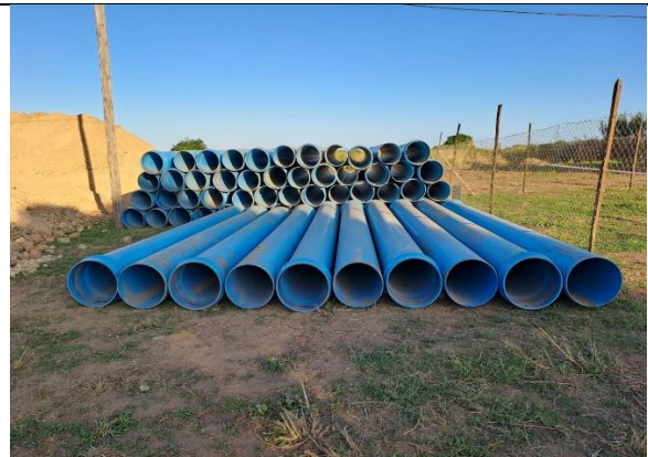
Tubagem de 500 mm recém-descarregados
