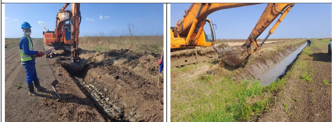
Limpeza de Valas secundárias no Chincumbua II
