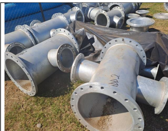
Material Armazenado no recinto do Estaleiro
