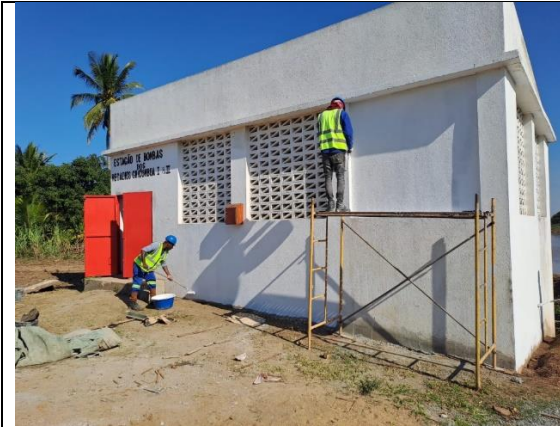
Pintura da Casa das Bombas
