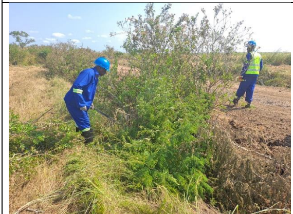
Limpeza manual de arbustos das valas de drenagem
