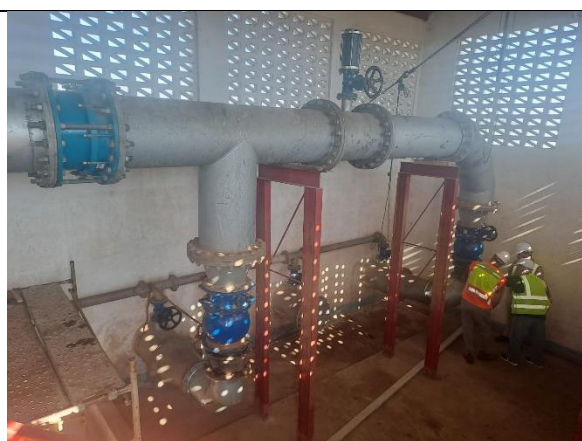
Reinstalação de Tubagem na estação de Bombagem
