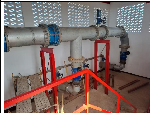
Tubagem na estação de bombagem Já conectadas aguardando apenas pelas Bombas
