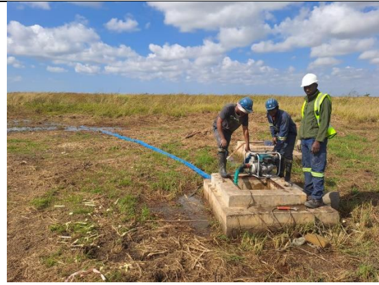
Drenagem da rede através da válvula de descarga
