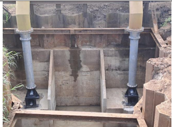
Colocação dos adaptadores das Bombas
