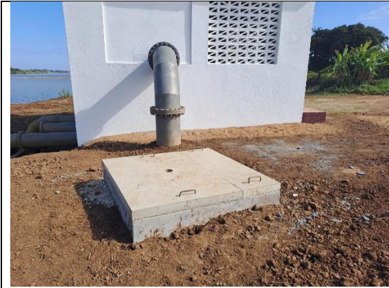
Caixa de Válvula de Bypass Já com tampa
