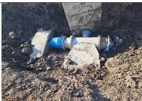
Ancragem de tubagem Adutora ora substituídos
