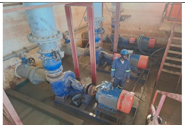
Trabalho de remoção das bombas
