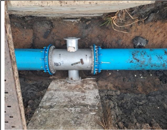
Montagem de novos acessórios
