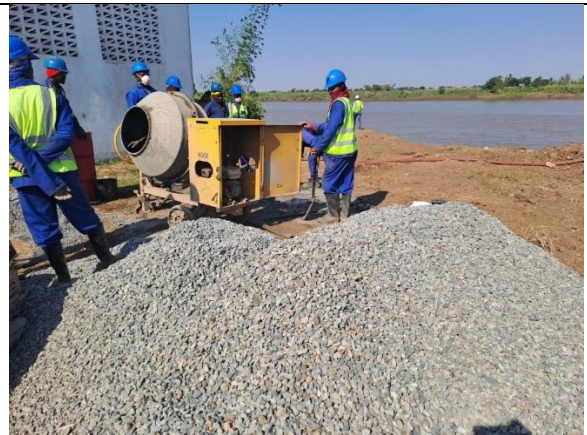
Trabalho de Betonagem de Maciço
