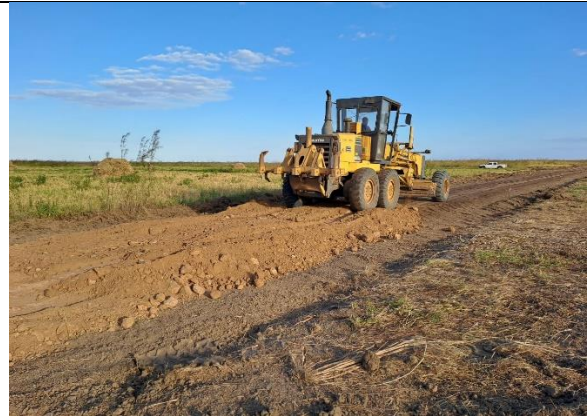
Nivelamento de solos proveniente de camara
