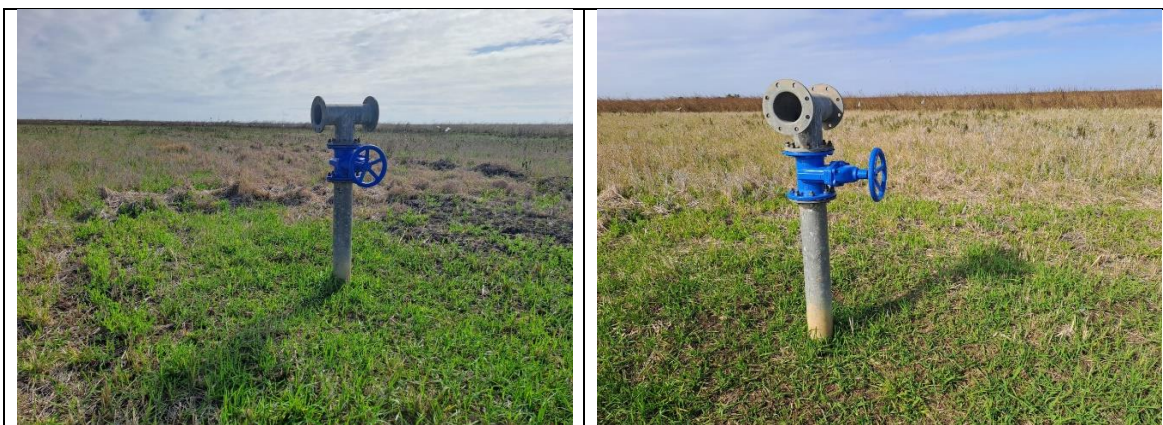
Hidrantes já acabados
