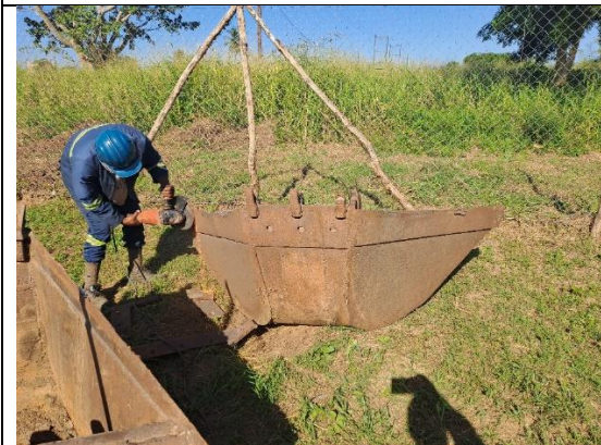
Preparação de Baldes para limpeza de canais
