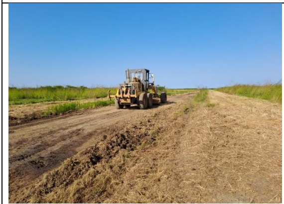
Nivelamento de Estradas
