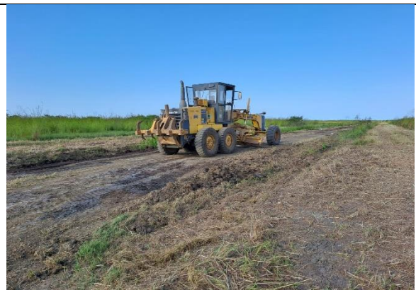
Nivelamento de Estradas
