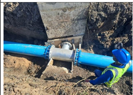
Ancragem de tubagem Adutora ora substituídos
