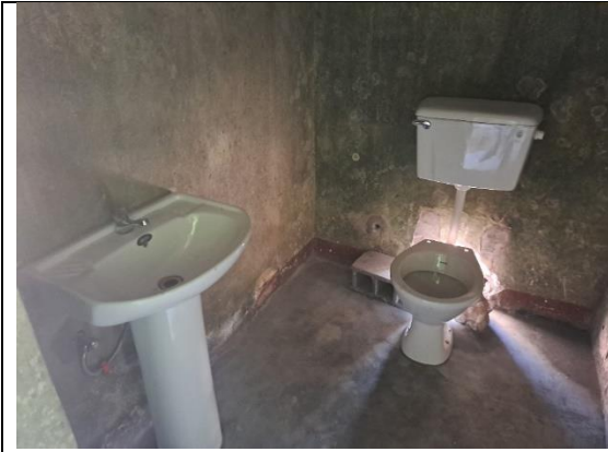
Instalação dos vasos sanitários no estaleiro
