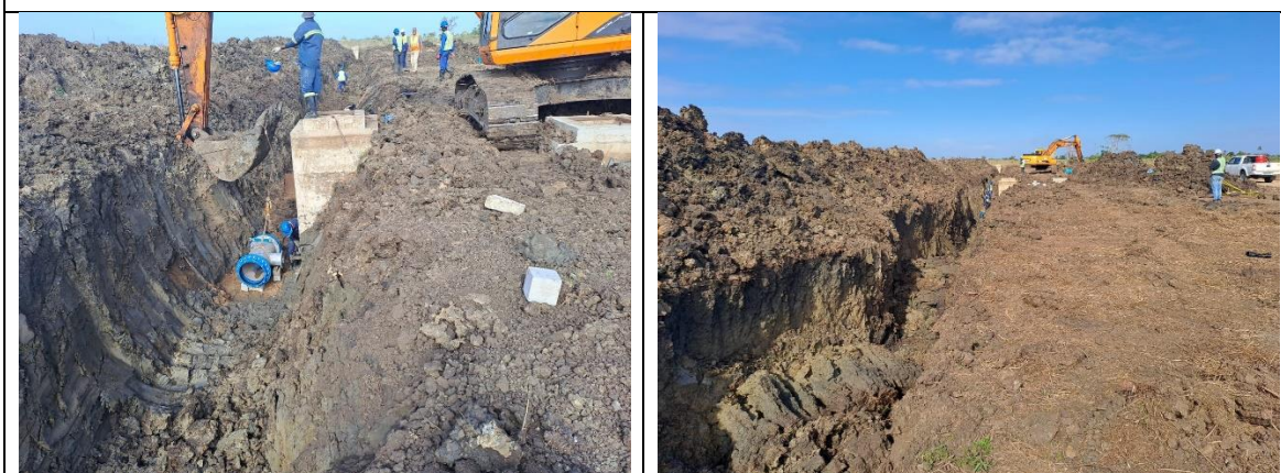
Instalação dos últimos 100 m de tubagem PVC e Acessórios
