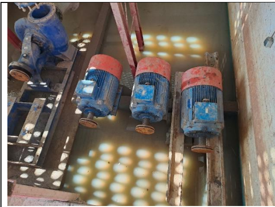
Motores das bombas retiradas do chace
