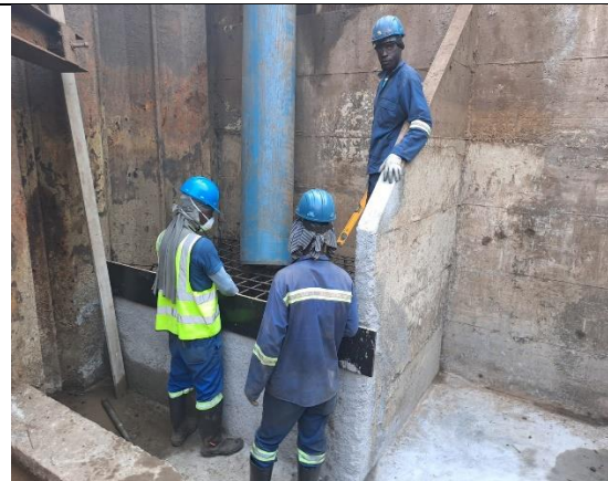
Trabalho de Betonagem de Maciço
