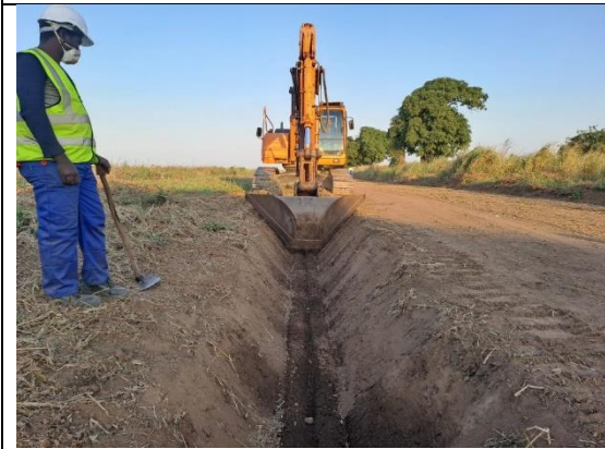
Trabalho de Limpeza de Valas de Drenagem
