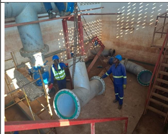
Remoção da tubagem na estação de bombagem para limpeza e a seguir possível reuso
