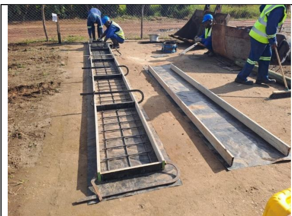
Fabrico de Tampas para reposição das destruídas pelas Cheias
