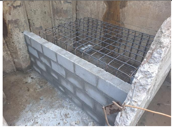
Preparação dos maciços das Bombas na captação
