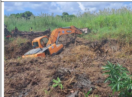
Escavadora enterrada próximo aos escritórios
