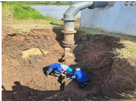
Escavação para o tubo Bypass
