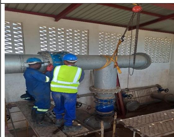
Reinstalação de Tubagem na estação de Bombagem
