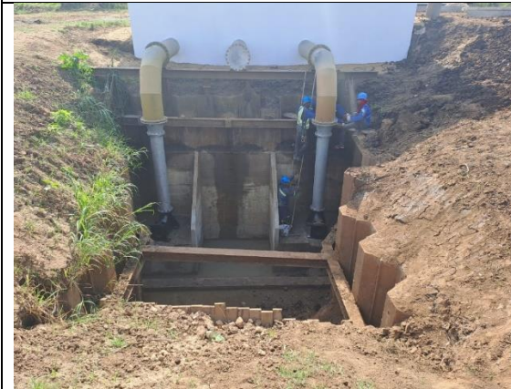
Colocação dos adaptadores das Bombas
